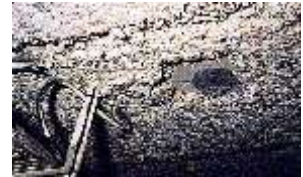
Flocage de plafond
