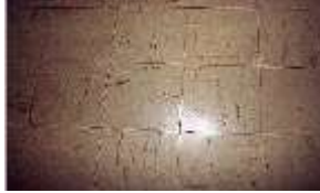
Dalles de sol
